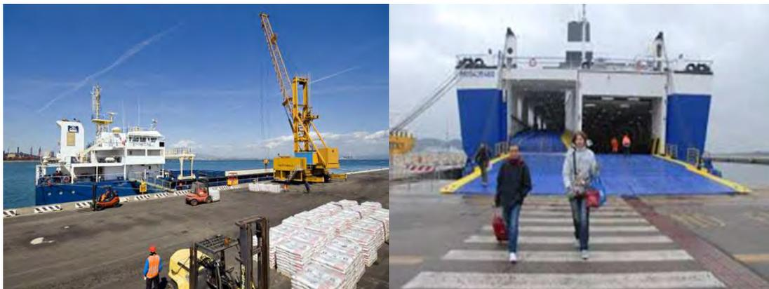
**Fig. IV-5 - Le aree di stoccaggio, circolazione, manovra e transito devono risultare ben definite nella organizzazione funzionale della viabilità interna di un'infrastruttura portuale**
