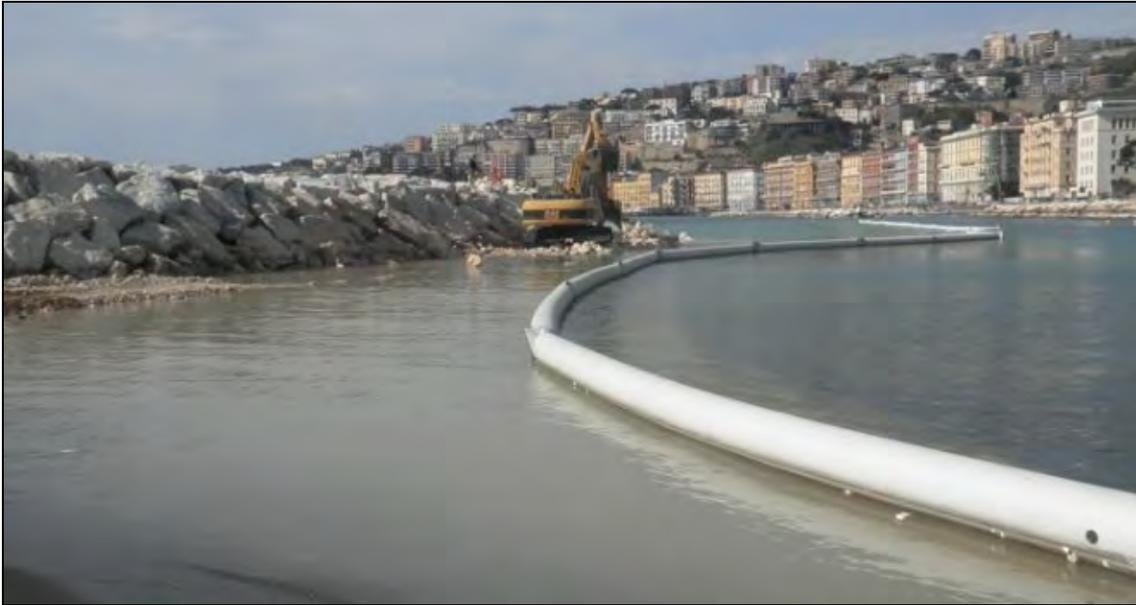
**Figura 9-1 Esempio di impiego di barriere anti-torbidità**
